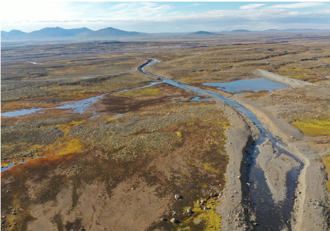
Stífla í Innri Sauðá og vatnsveiting um skurð til Grjótár. Ljósmynd IRJ.
