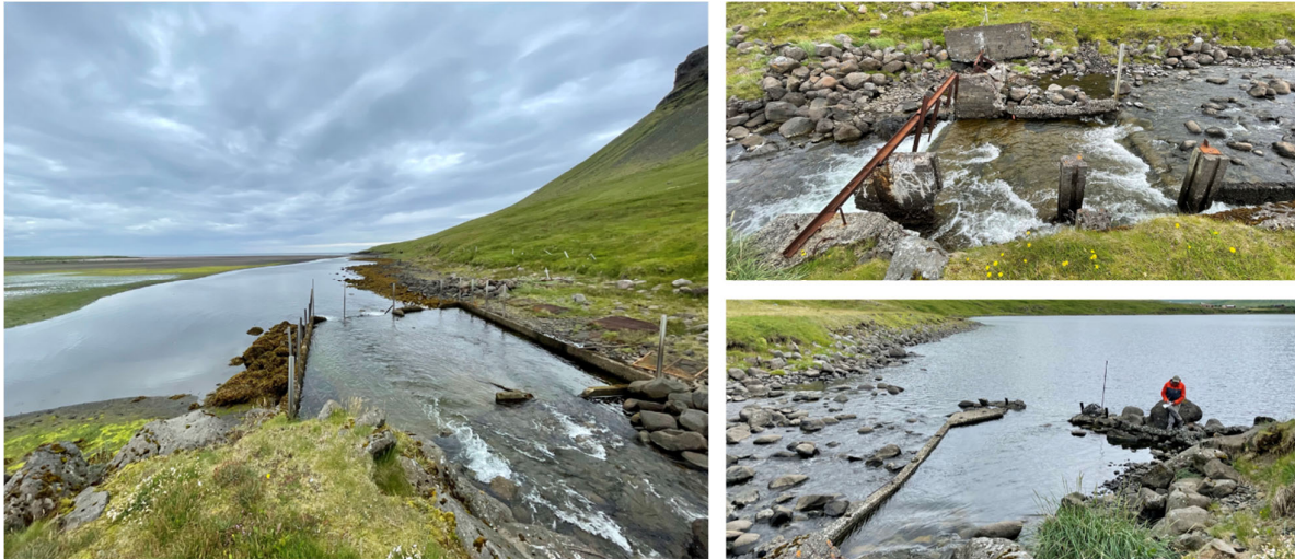
3. mynd Útfall Lárvaðals úr innra lóni yfir í ytra lón. Myndir teknar á smástreymi og fjöru. Á myndinni sjást gildru mannvirki frá því er hafbeitt var í Lárós frá 1965-2004. Á vinstri mynd er horft út til sjávar og á neðri mynd til hægri er horft inn til lands.
